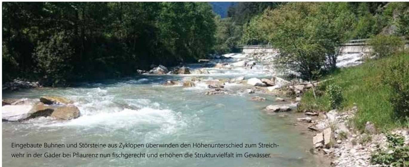
Eingebaute Buhnen und Störsteine aus Zyklosteinen überwinden den Höhenunterschied zum Streichwehr in der Gader bei Pflaurenz nun fischgerecht und erhöhen die Strukturvielfalt im Gewässer.
