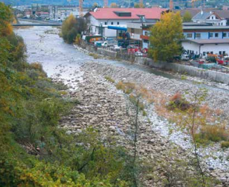
Hier wurde der Eisack (Restwasserstrecke) für den Bau eines Radweges auf die andere Bachbettseite verlegt. Die trockengelegte Strecke wurde vorher abgefischt. Die Arbeiten wurden vergütet und nach Abschluss der Arbeiten ein Besatz mit Marmorierten Jungfischen vorgenommen
