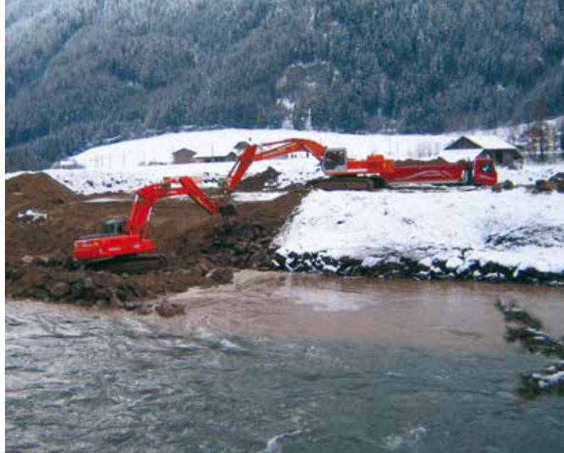
Arbeiten zur Verlegung der Rienz bei Vintl. Die Trübung ist deutlich zu sehen. Als Entschädigung wurde der Besatz von 2000 Marmorierten 6 – 9 cm und 1000 Marmorierten 15 – 21 cm vereinbart und auch durchgeführt
